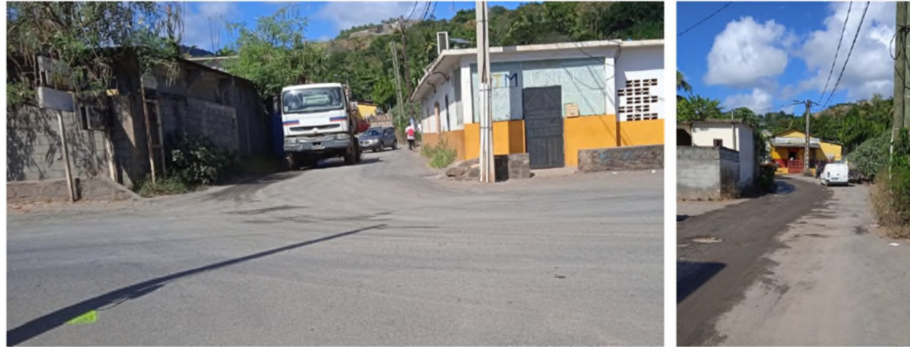
Carrefour et voie de desserte à la carrière (à gauche) et voie de desserte de la carrière (à droite)
